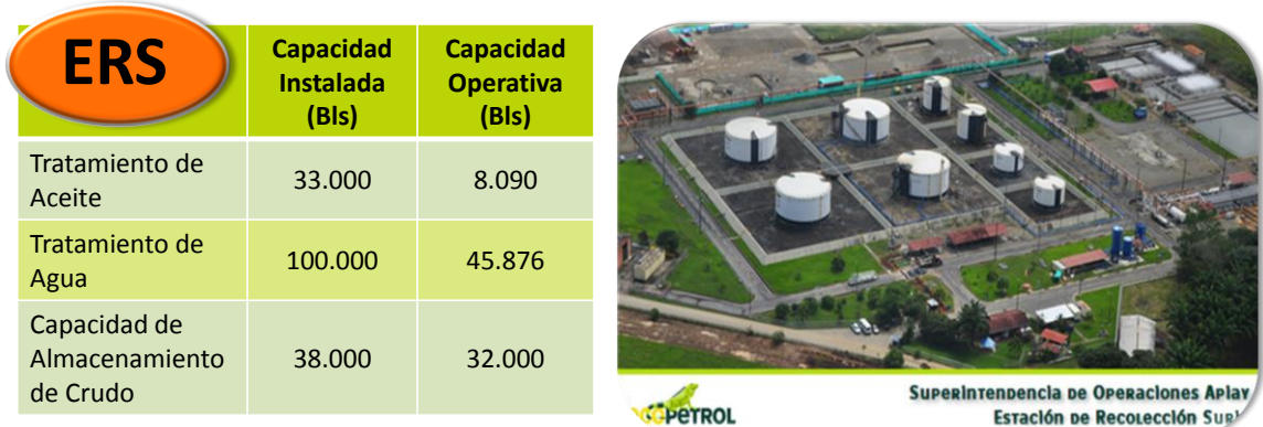
Figura 3. Infraestructura Estación de Recolección Suria (ERS)
