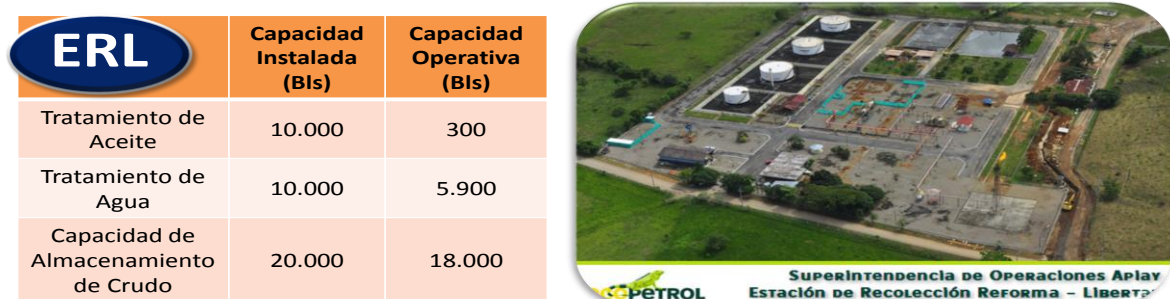
Figura 4. Infraestructura Estación de Recolección Reforma-Libertad (ERL)
