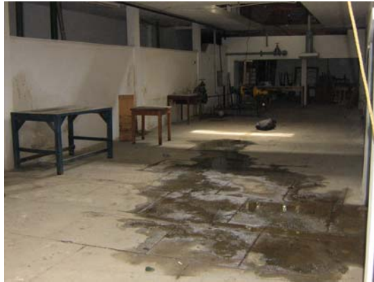
Figura 78. Paredes del primer nivel, sección tanque de agua.
