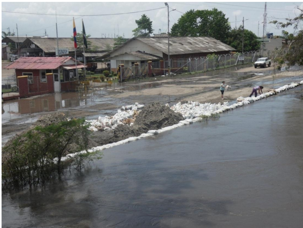
Imagen 12. Sacos de arena conteniendo el desbordamiento del Río.
