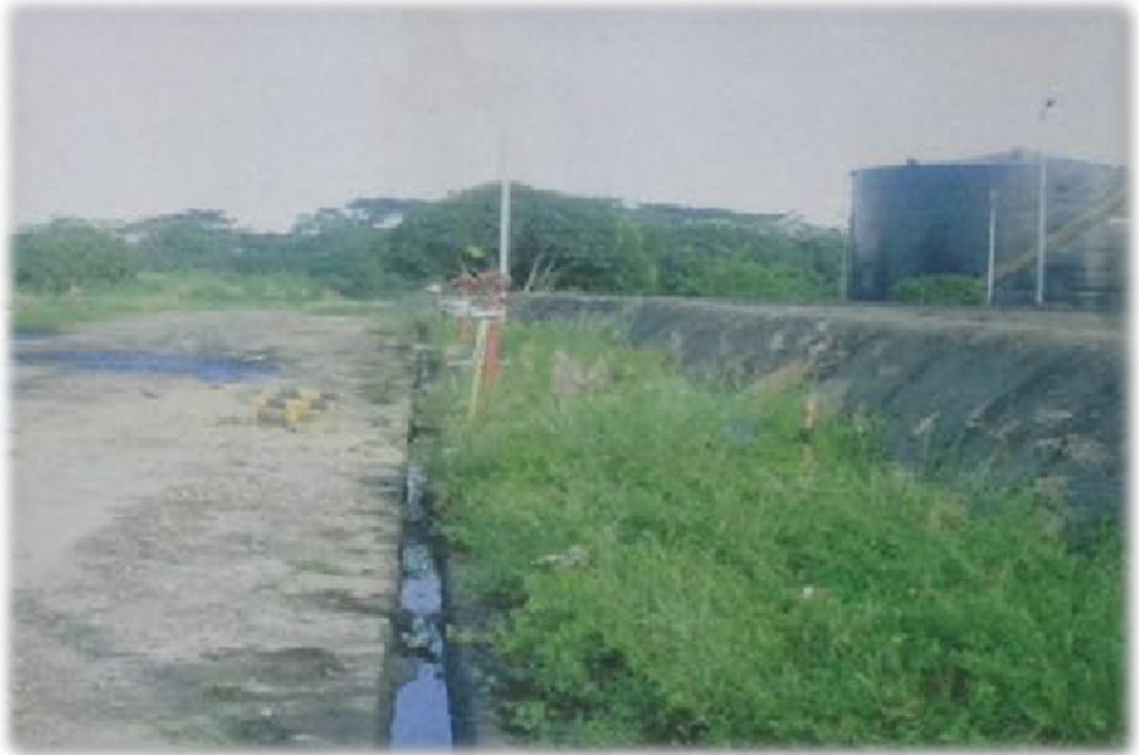
Foto: Cunetas con crudo en estación Isla VI del Campo Cantagallo-Yariguí.
