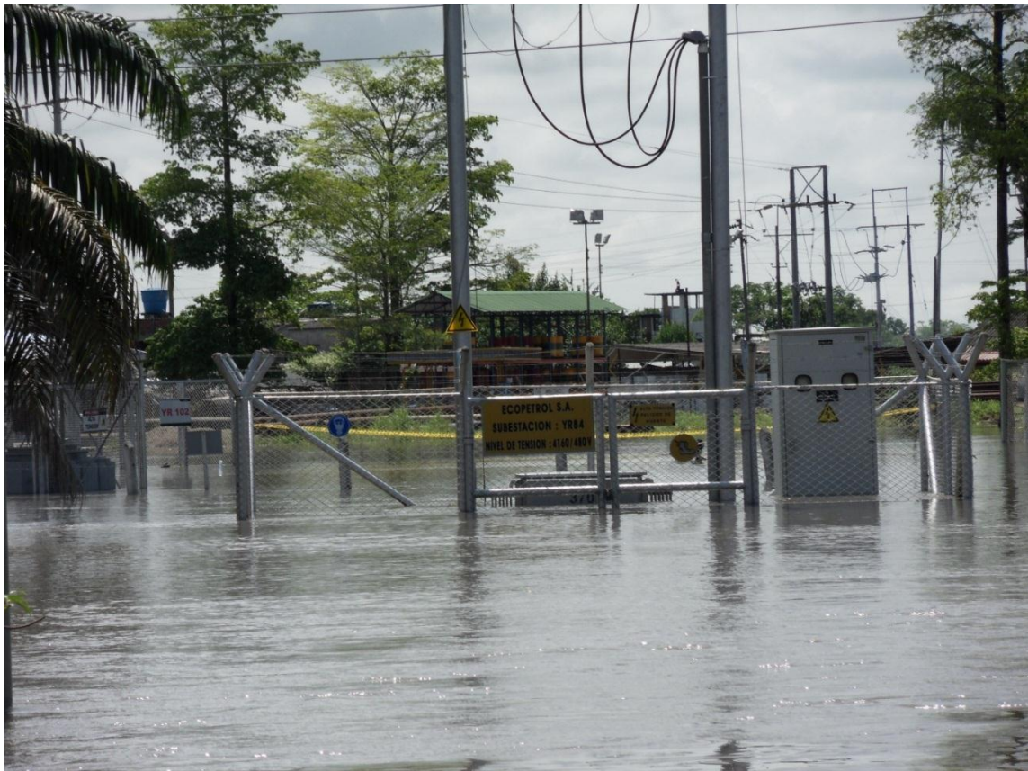
Imagen 13. Subestación inundada
