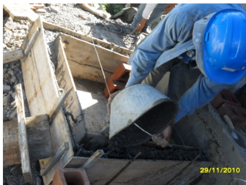
Fotografía 18. Se funde viga cinta.
