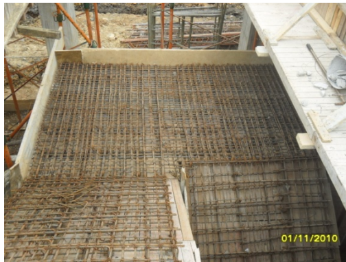
Fotografía 17. Detalle refuerzo para descanso de escalera.
