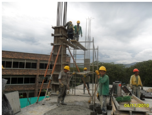
Fotografía 12. Se funde columna.
