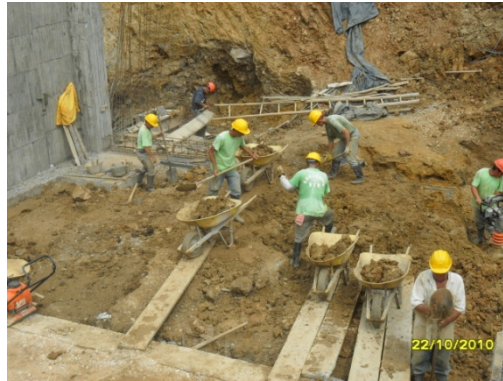
Fotografía 1. Excavación y retiro de material común, Placa de contrapiso.
