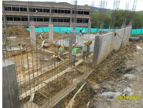
Fotografía 13. Refuerzo para muro de contención.
