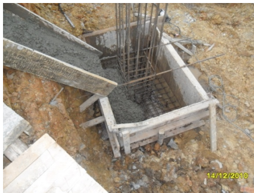
Fotografía 10. Se funde zapata.
