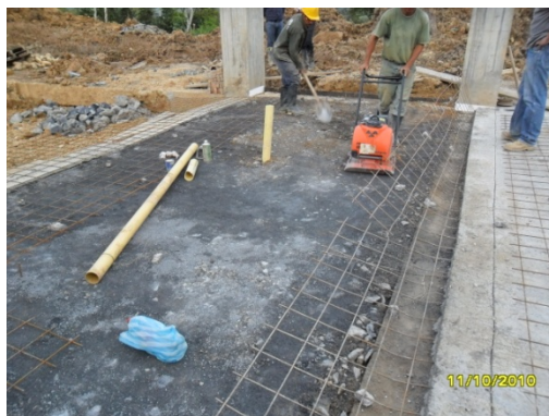
Fotografía 3. Compactación de base granular, Placa de contrapiso.
