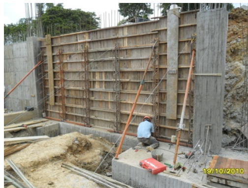
Fotografía 14. Formaleta para muro de contención.
