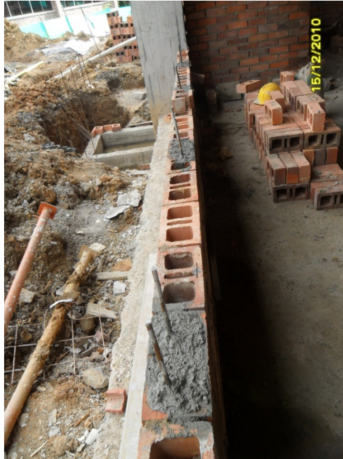
Fotografía 21. Castillos para confinamiento de la mampostería a la vista.
