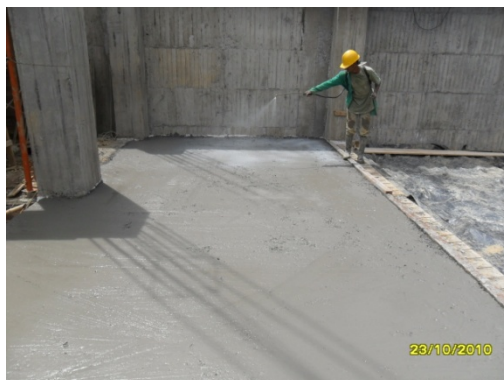
Fotografía 8. Curado placa de contrapiso, utilizando Antisol.
