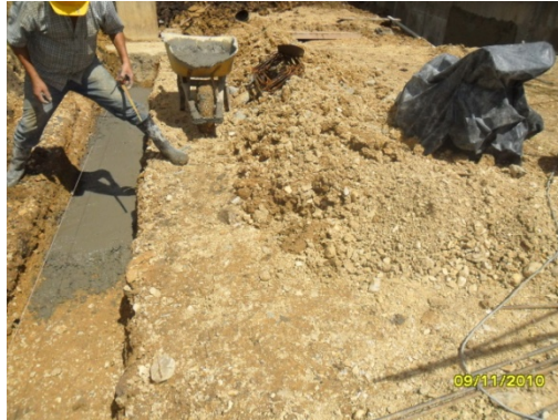
Fotografía 5. Se funde solado para vias de amarre.
