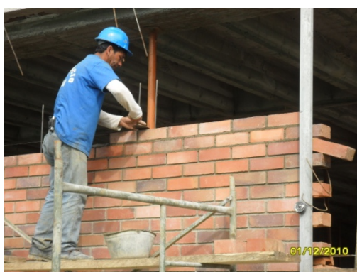
Fotografía 20. Construcción de muros en ladrillo a la vista.
