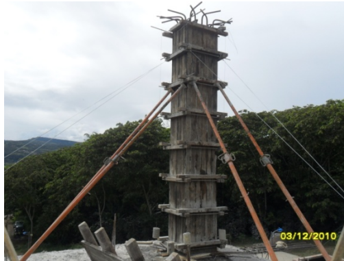
Fotografía 11. Formaleta para columna.
