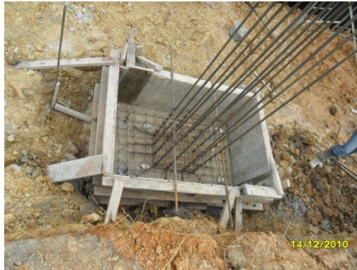
Fotografía 9. Refuerzo para zapata.
