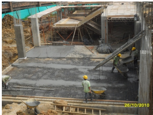
Fotografía 7. Se funde placa de contrapiso.
