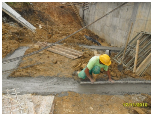
Fotografía 6. Nivelación de solado para vigas de amarre.
