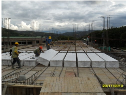
Fotografía 15. Colocación de casetón para placa aligerada.
