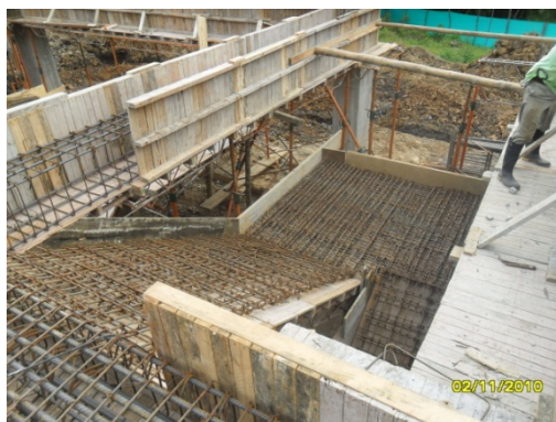
Fotografía 16. Refuerzo para escalera.
