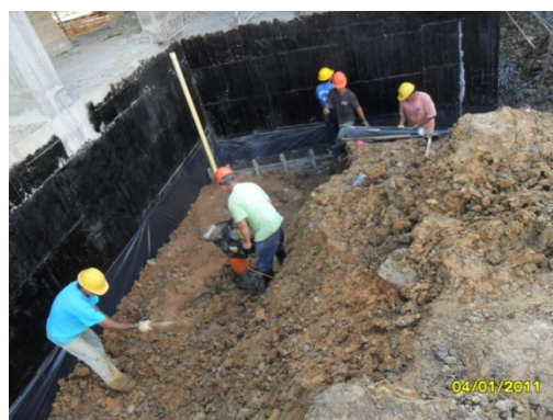
Fotografía 2. Compactación de material común.
