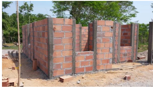
Figura 15. Grupo 7. Excavación, amarre y colocación del acero.
