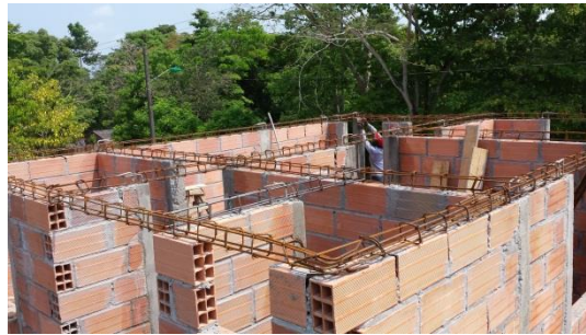
Figura 16. Grupo 8. Excavación, amarre y colocación del acero.
