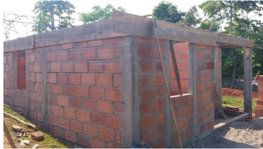
Figura 17. Grupo 9. Excavación, amarre y colocación del acero.
