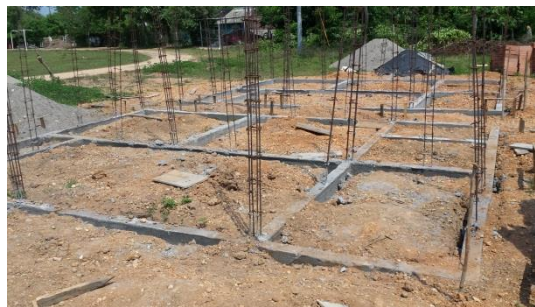
Figura 12. Grupo 4. Excavación, amarre y colocación del acero..
