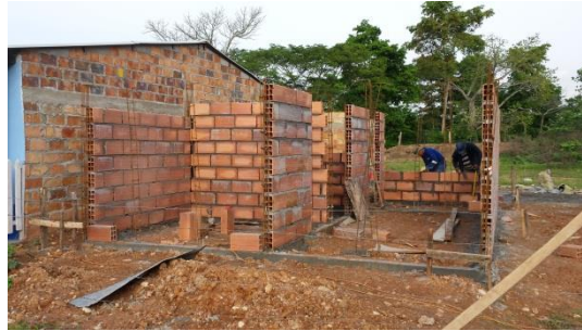
Figura 14. Grupo 6. Excavación, amarre y colocación del acero.
