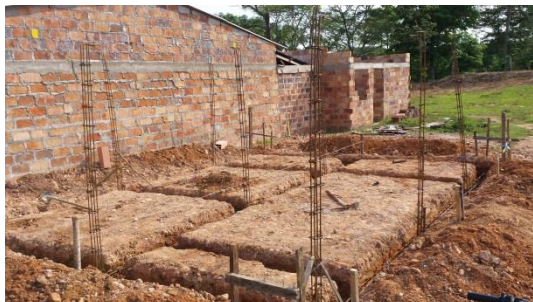
Figura 10. Grupo 2. Excavación, amarre y colocación del acero.
