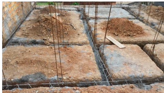
Figura 11. Grupo 3. Excavación, amarre y colocación del acero.
