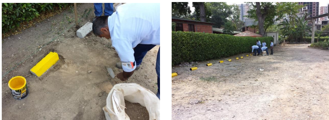
Figura 13 Instalación de las señalizaciones parqueadero
