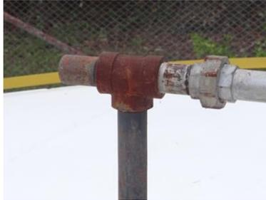
**Ilustración 24. Unión en T de la línea de entrada en el techo del tanque K02**
