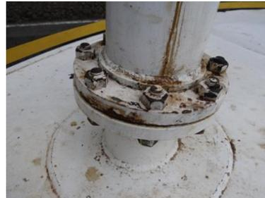
**Ilustración 10. Boquilla de medición de nivel del tanque K01**
