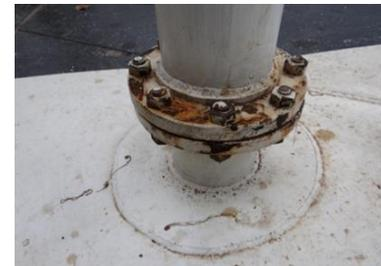
**Ilustración 28. Boquilla de medición de fluido del tanque K02**
