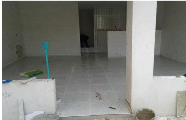
Figura 24. Estucado de paredes y columnas.
