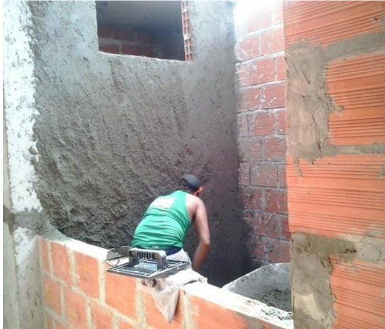
Figura 23. Revoque o pañete en muro
