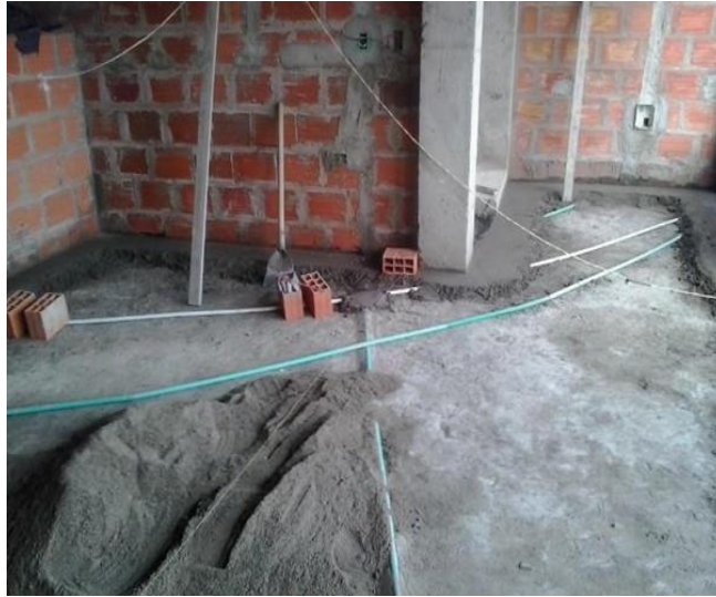
Figura 22. Alistado de piso y aplicación de mortero.
