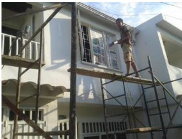
Figura 25. Pintura Fachada y carpintería metálica.
