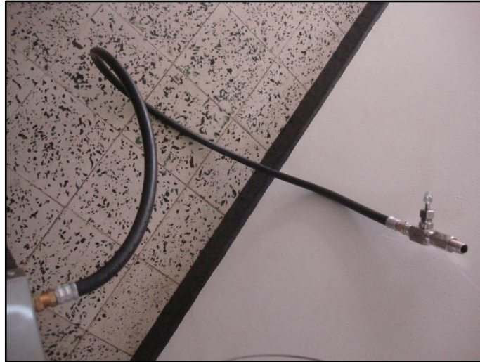
Figura 7. Línea de descarga a la sección de prueba
