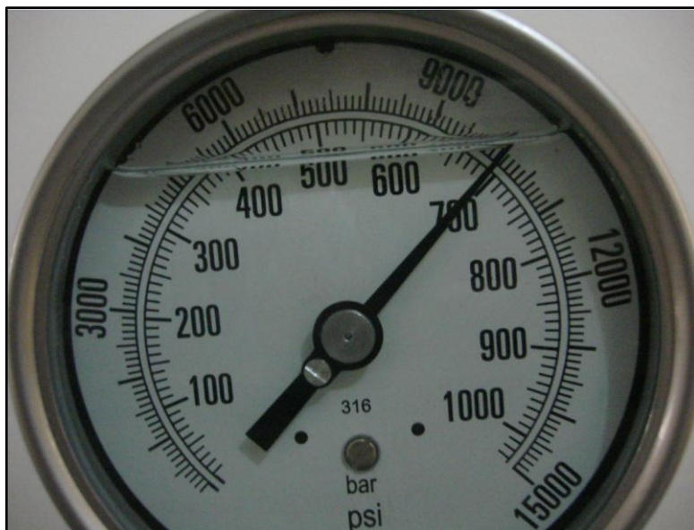
Figura 270. Presión de prueba-bomba 10000 psi
