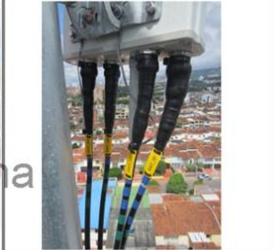
Enrutamiento, marquillas (incluye cintas de colores) e impermeabilización de conectores en antena (PRIMER PLANO)
