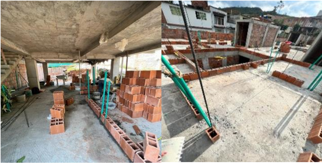
Replanteo de viviendas
