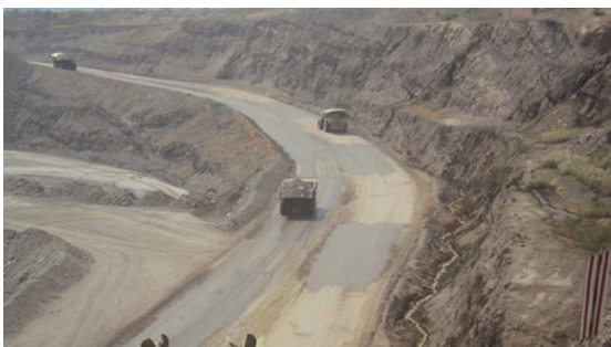
Figura 2. Fotografía de Rampa de 500 m de longitud utilizada para la prueba.
