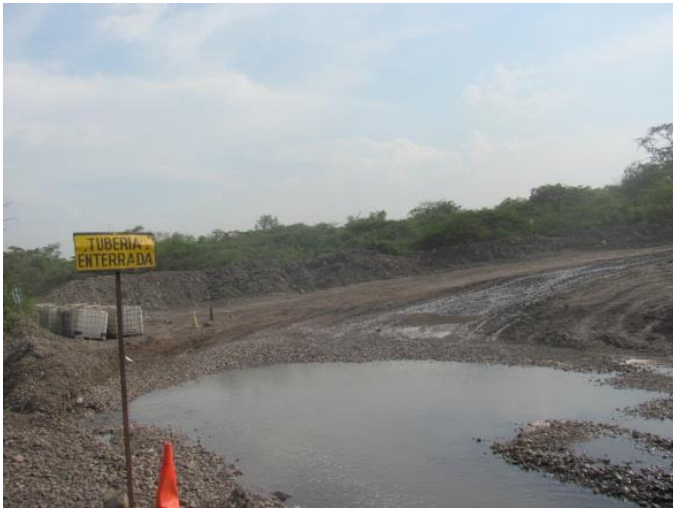
Figura 5. Fotografía de Piso de torre de llenado Gloria.
