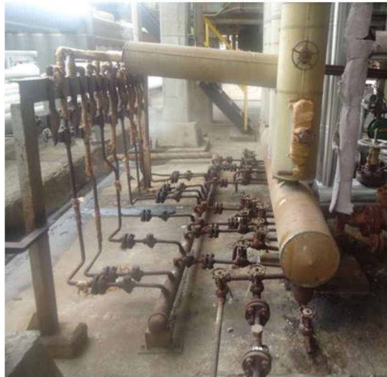
Cabezal ubicado en el lado occidental del horno H-254
