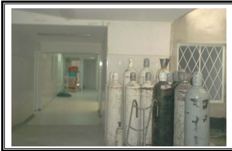
Figura 13. Pasillo de mantenimiento
