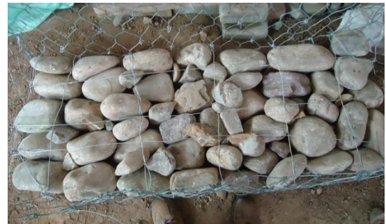
Figura 5. Tirantes horizontales del gavión tradicional
