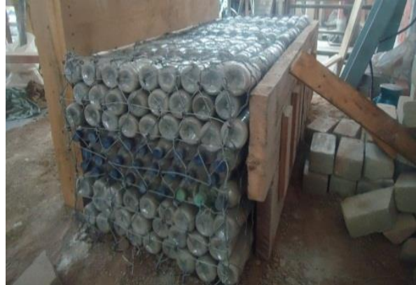
Figura 10. Entibado del gavión
