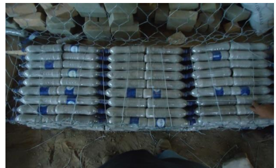
Figura 11. Tirantes horizontales del gavión con botellas PET
