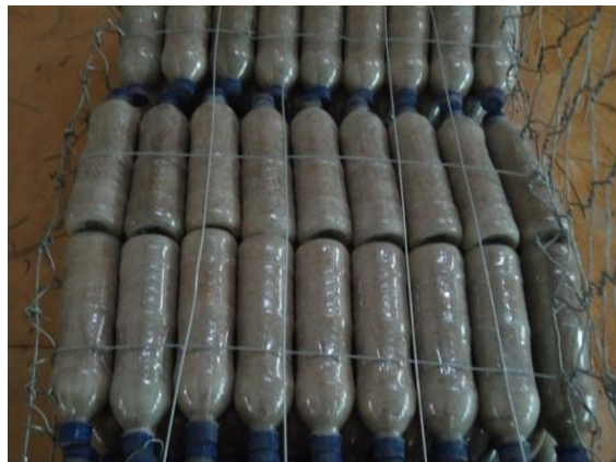
Figura 15. Tirantes entre paneles laterales, espaciamiento cada 10 cm.
