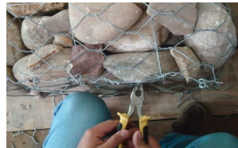
Figura 6. Cierre y amarre de la tapa del gavión.
