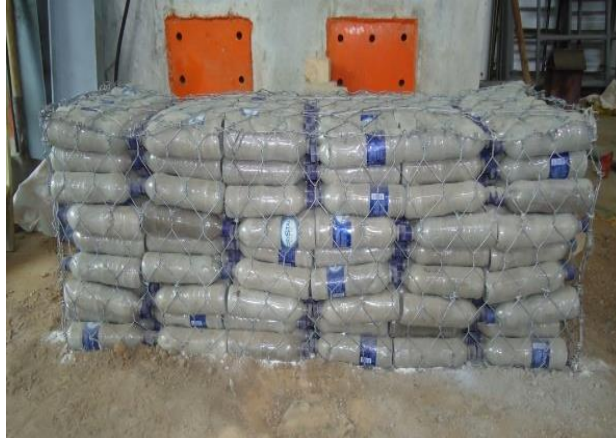
Figura 18. Gavión con Botellas PET terminado.
