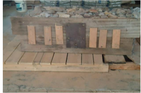
Figura 4. Estructura en madera que simula el empuje del suelo
