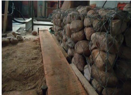
Figura 22. Apoyo para evitar el deslizamiento de la estructura
