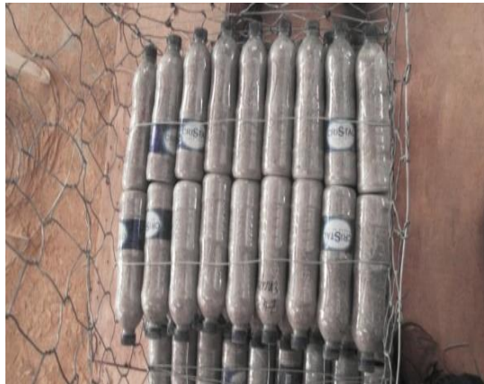
Figura 14. Tirantes entre panel frontal y trasero, espaciamiento cada 25 cm.
