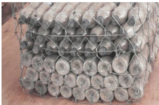
Figura 13. Cambio de dirección botellas acostada
