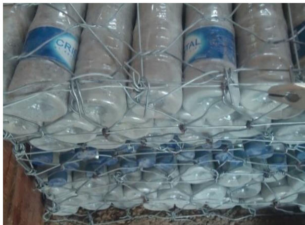
Figura 17. Costura y Cierre de la tapa de la canasta.
