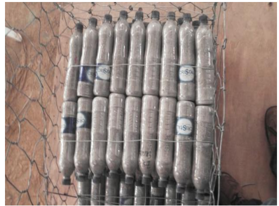
Figura 10. Tirantes sobre las hiladas de botellas PET
