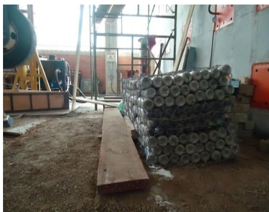
Figura 24. Volcamiento de la estructura
