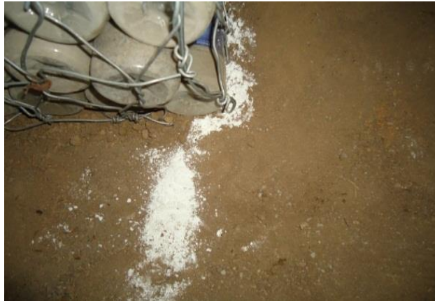
Figura 20. Desplazamiento de la unidad de gavión relleno de botellas PET.
