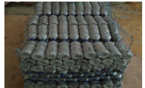
Figura 12. Vista lateral del gavión con botellas PET
