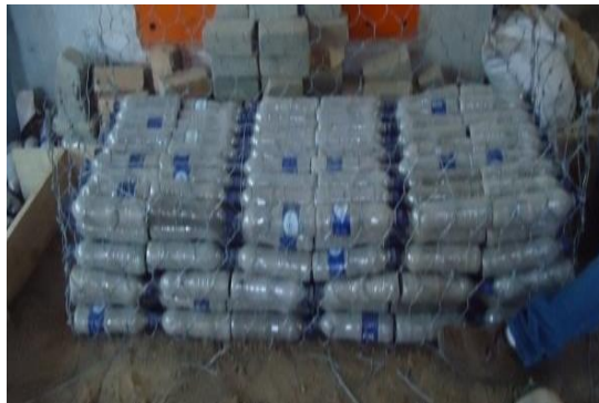
Figura 12. Posicionamiento de las botellas
