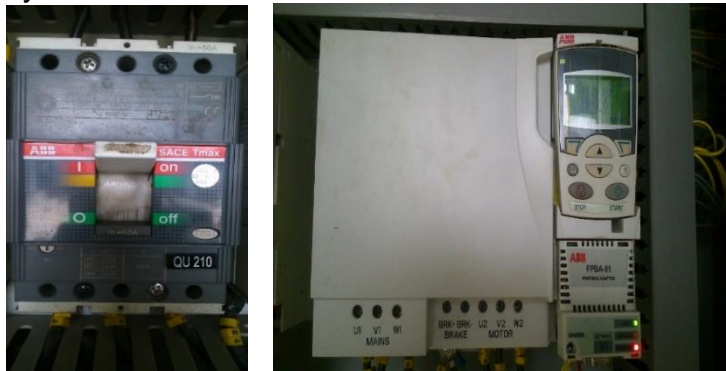
Figura 22. Variador y braker ABB del tambor desfrutador
