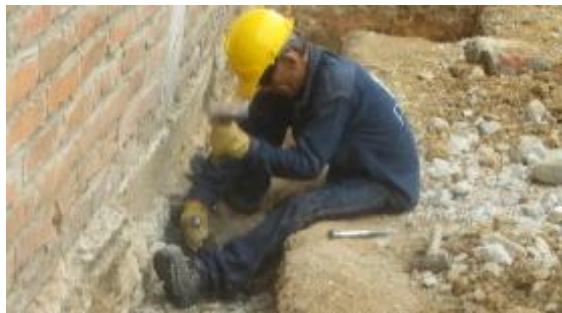
Figura 12. Zapatas de construcciones vecinas invadiendo el lote.
