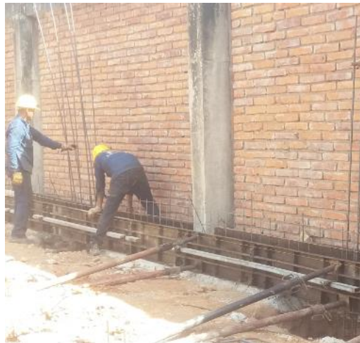
Figura 13. Encofrado y ajuste de las vigas de cimentación Bodega Ricardo Pradilla.
