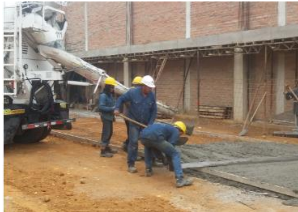
Figura 15. Fundida de la placa de contrapiso.
