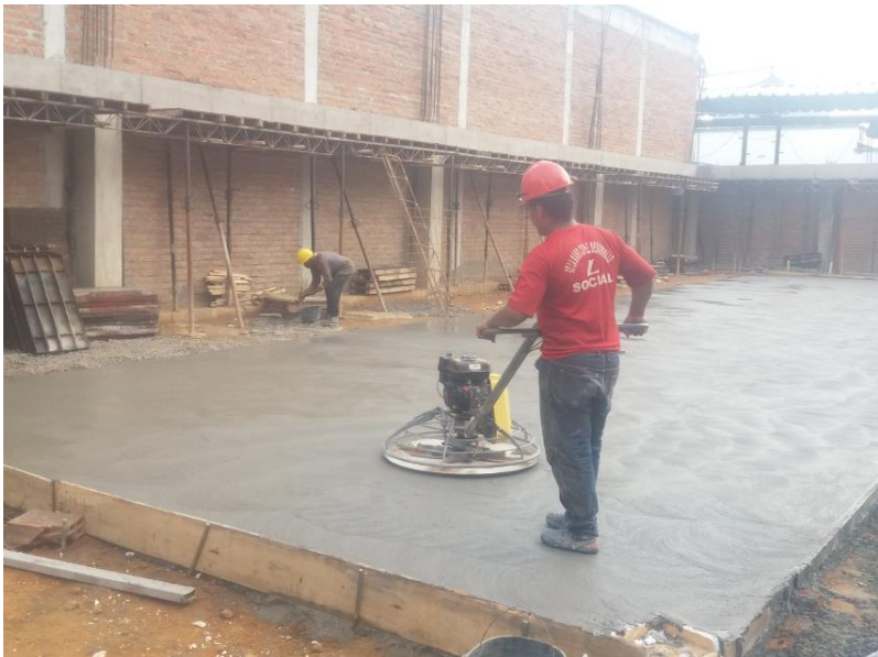
Fundida de la placa de contrapiso bodega de Ricardo Pradilla
