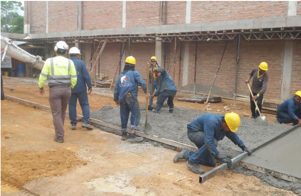
Fundida de la placa de contrapiso bodega de Ricardo Pradilla
