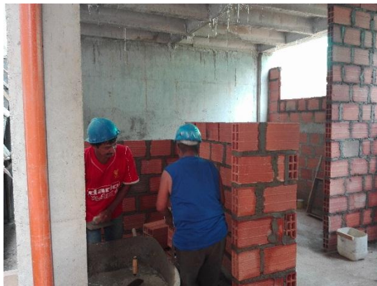
Figura 6. Construcción muro de mampostería.
