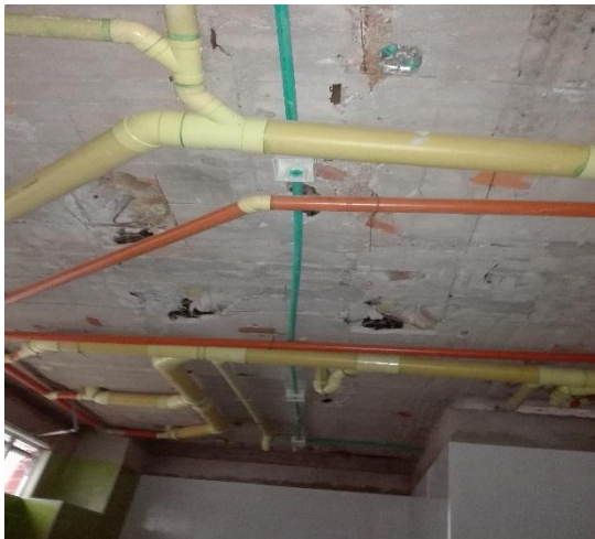
Figura 9. Red de tubería sanitaria
