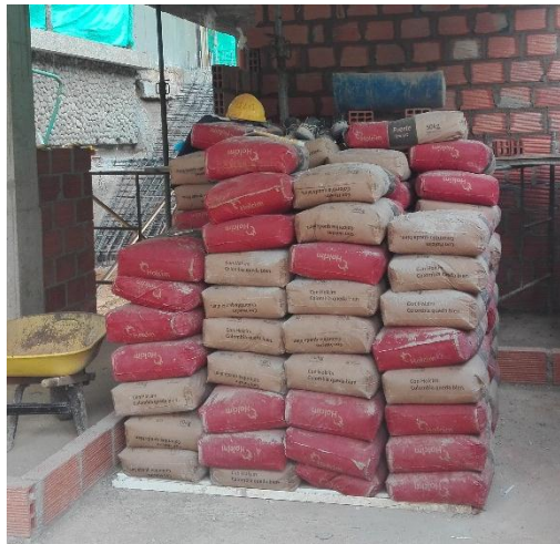
Figura 3. Almacenamiento de cemento.
