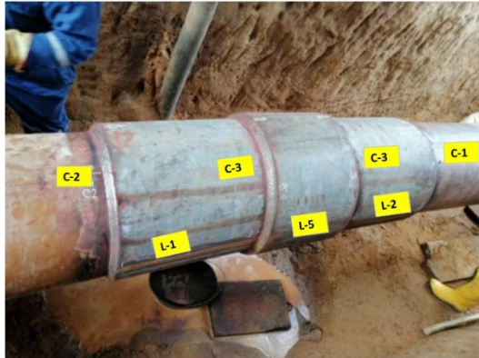
Fotografía 2. Instalación camisa metálica tipo B km 1+130 Troncal PST1-CCPF
