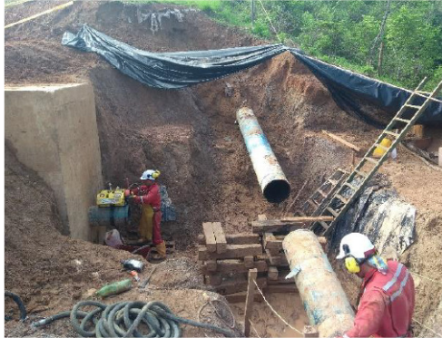
Fotografía 6. Reemplazo de tramo de tubería
