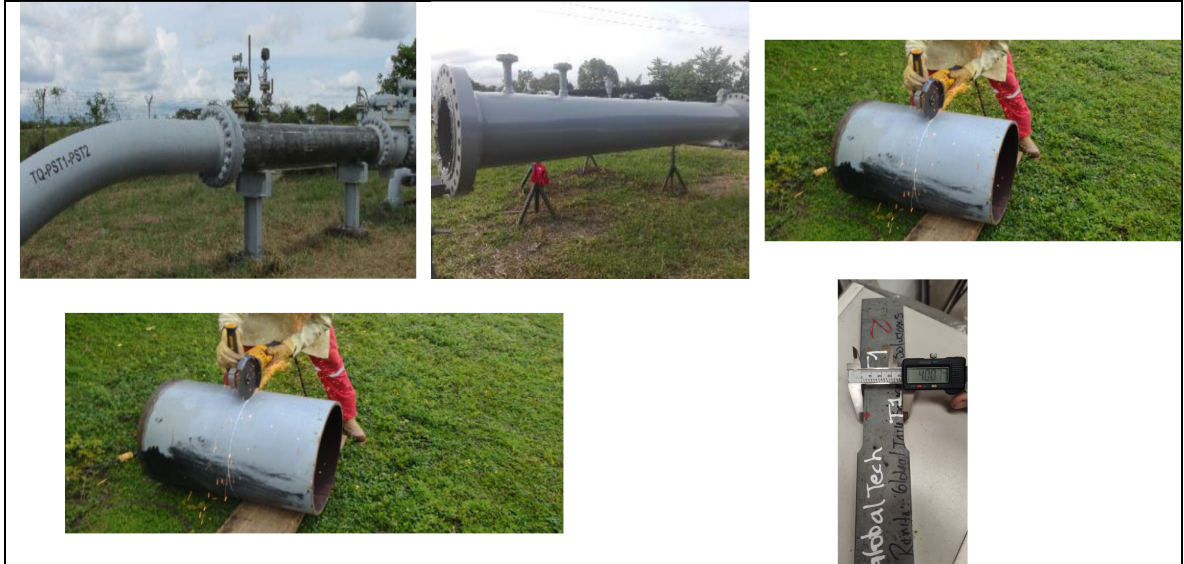
Fotografía 4. Tramo de tubería retirado para pruebas de tensión
