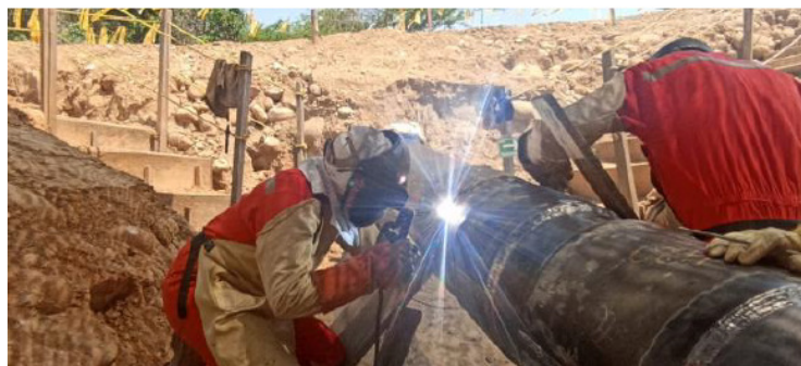
Fotografía 7. Instalación de Full Encirclement Steel Sleeve
