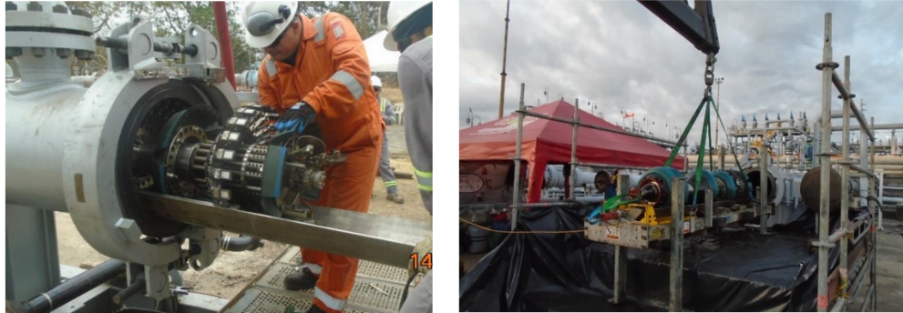
Fotografía 3. Detalles herramienta inteligente Troncal PST1-PST2-CPF 2020
