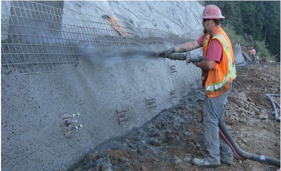
Fotografía 3. Hormigón proyectado.
