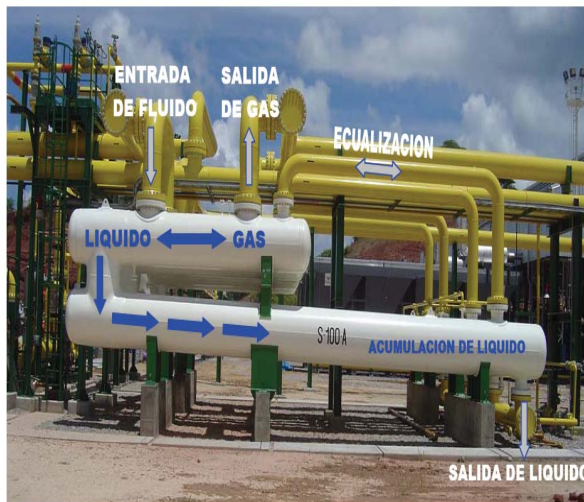
Figura 15. Funcionamiento de Slug Catcher Tipo Tubería
