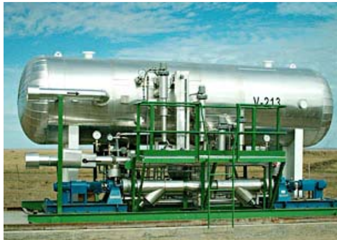
Figura 14. Separador Knockout Drum
