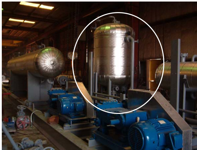
Figura 27. Filtro de carbón activado.
