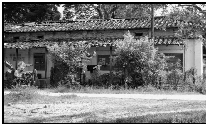
Figura 12. Vista frontal del antiguo casino del Ferrocarril en la Estación Provincia
