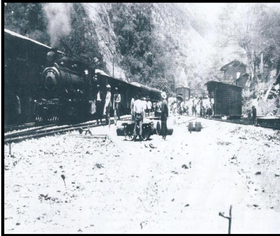
Archivo Leonor Wilches. Foto. Gustavo Wilches Fotog. Inspección de Trabajos en zona de Derrumbe
