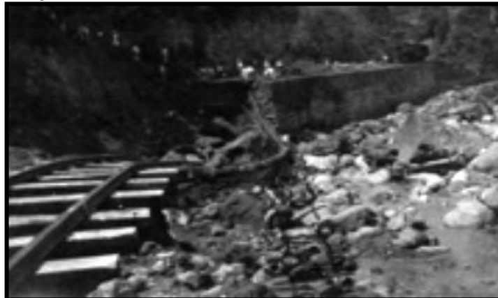
Figura 6. Inicio de la Construcción del Ferrocarril de P. Wilches
