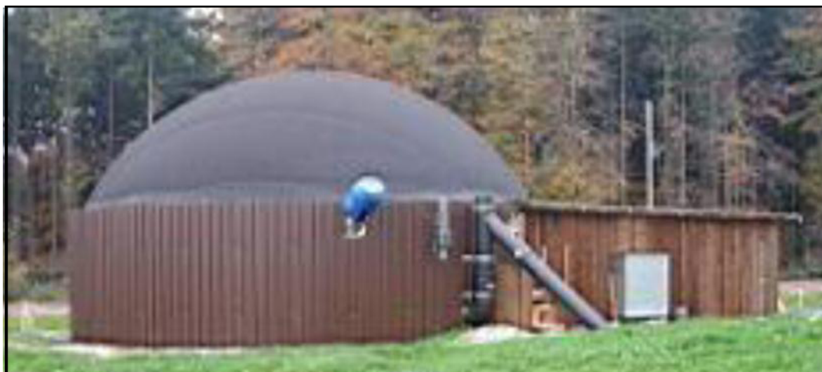
Figura 9. Biodigestor tradicional y cúpula de polietileno.
