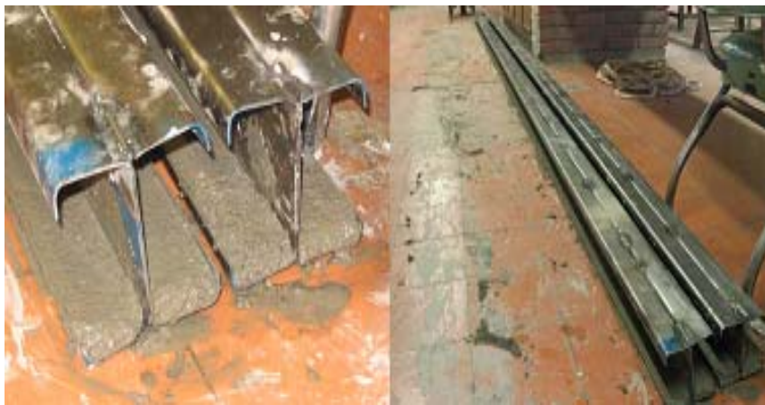
Fotografía 10. Capa de Mortero
