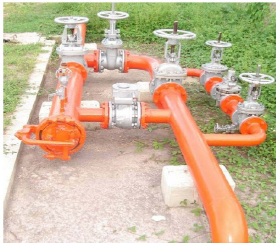
Figura 13. Trampa para raspadores.
