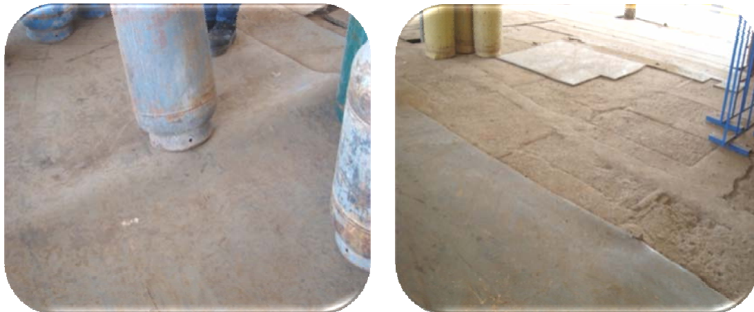
Figura 18. Condiciones del suelo en plataforma.
