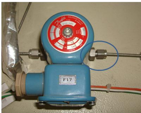
Figura A11. Conexión de las electroválvulas.
