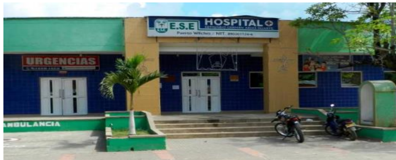
Figura 1. Instalación externa E.S.E EGA.
