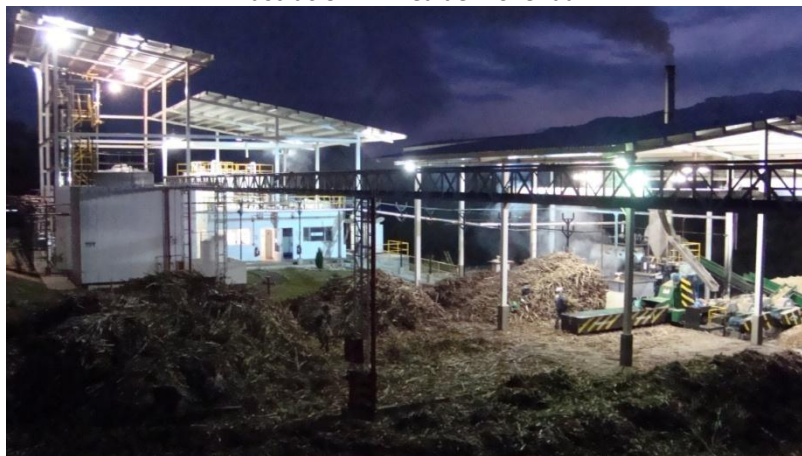
Ilustración 1. Área de molienda
