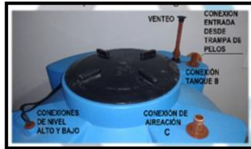
Conexiones cisterna biológica
