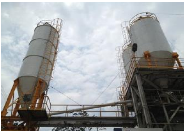
Figura 8. Silos planta surata.
