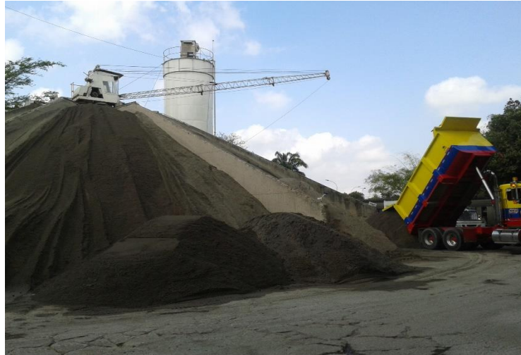
Figura 10. Almacenamiento de agregados, Planta Florida F016
