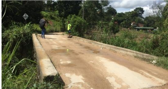
Figura 3. Puente vehicular localizado en la vereda Pajonal.
