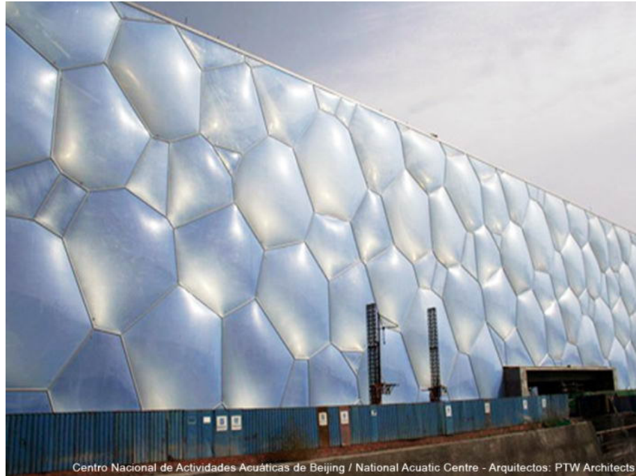
Figura 3 Recubrimiento estructural con ETFE
