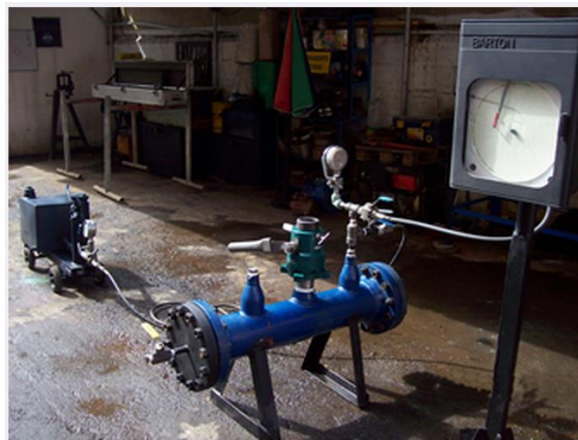
Figura 7. Pruebas Hidrostáticas y Limpieza de Oleoductos
