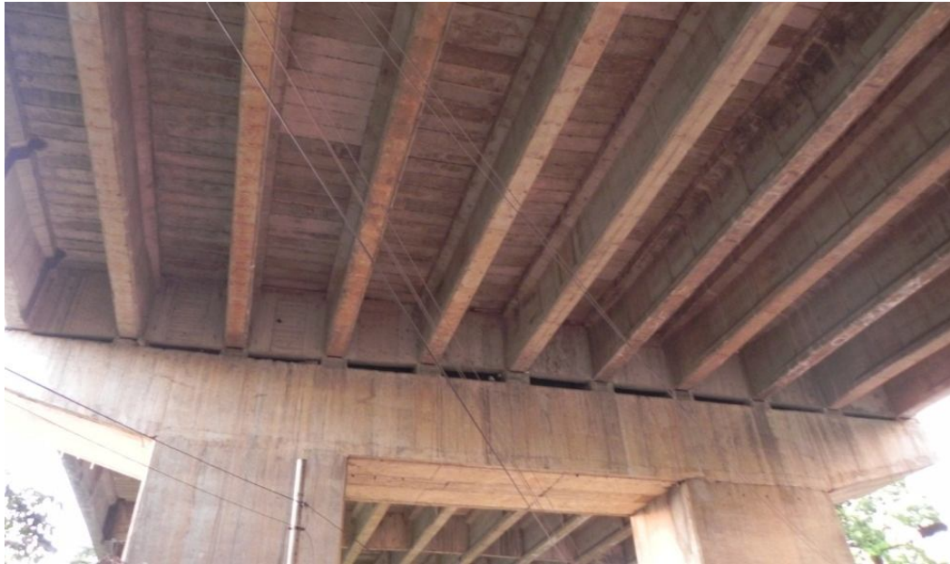
Ilustración 8: Vigas postensadas apoyadas sobre la viga cabezal.
