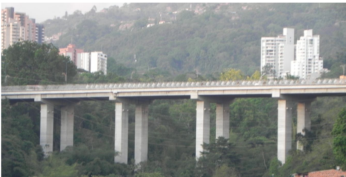
Ilustración 2: Viaducto Armando PuyanaPuyana o La Flora.
