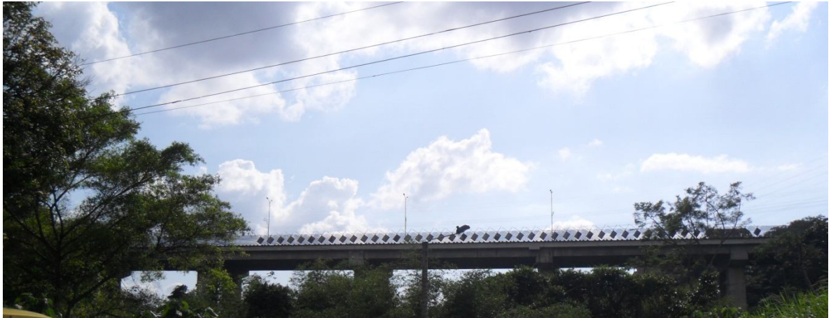
Ilustración 3: Vista lateral del viaducto La Flora.
