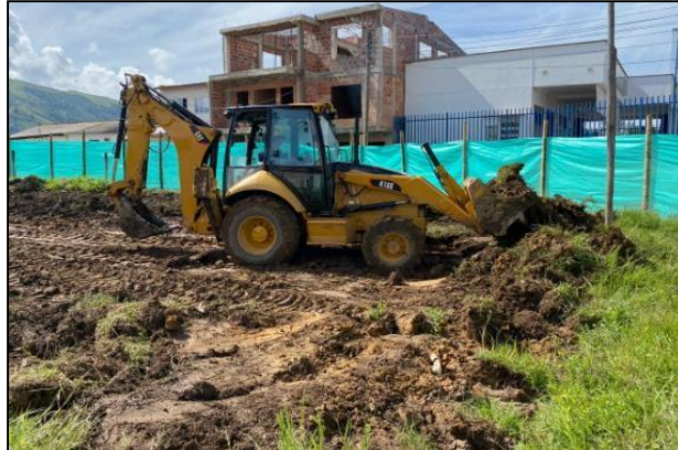
Figura 10. Acarreo y retiro de material
