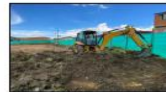
Fotografía 9 Desmonte y descapote
