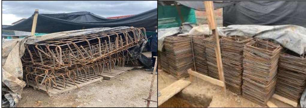
Figura 15. Acero de refuerzo de zapatas y de vigas de amarre
