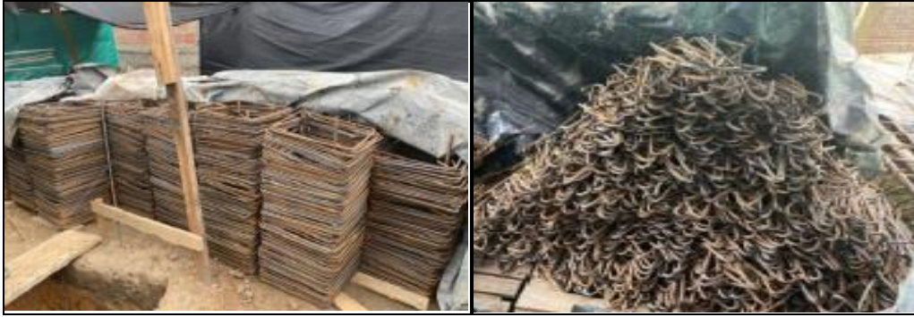
Figura 16. Acero de refuerzo para estructura
