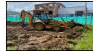
Fotografía 7 Acarreo y retiro de material
