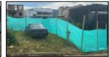
Fotografía 6 Cerramiento vivienda Sr. Nestor Jerez y calle 8ta
