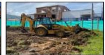
Fotografía 10 Desmonte y descapote
