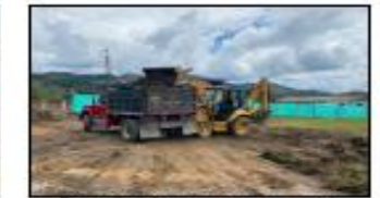
Fotografía 8 Cargue y retiro de material.
