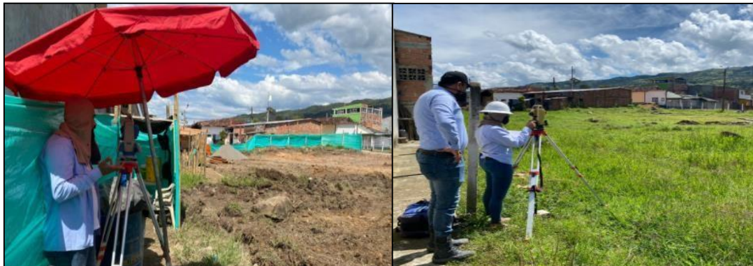
Figura 9. Trazado de ejes e implantación
