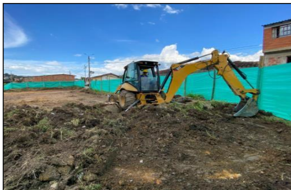
Figura 11. Desmonte y descapote
