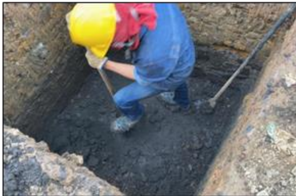
Figura 12. Excavación manual
