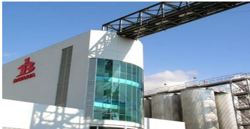
Figura 6. Edificio cocinas cervecería Bavaria Bucaramanga
