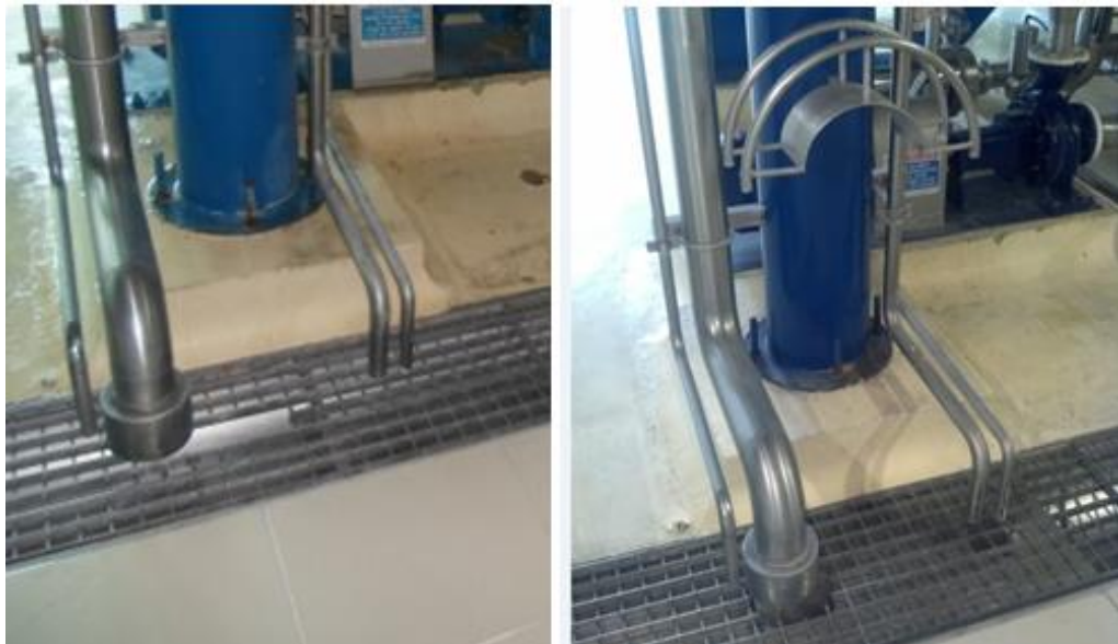
Figura 67.Desagüe de proceso. Antes y después
