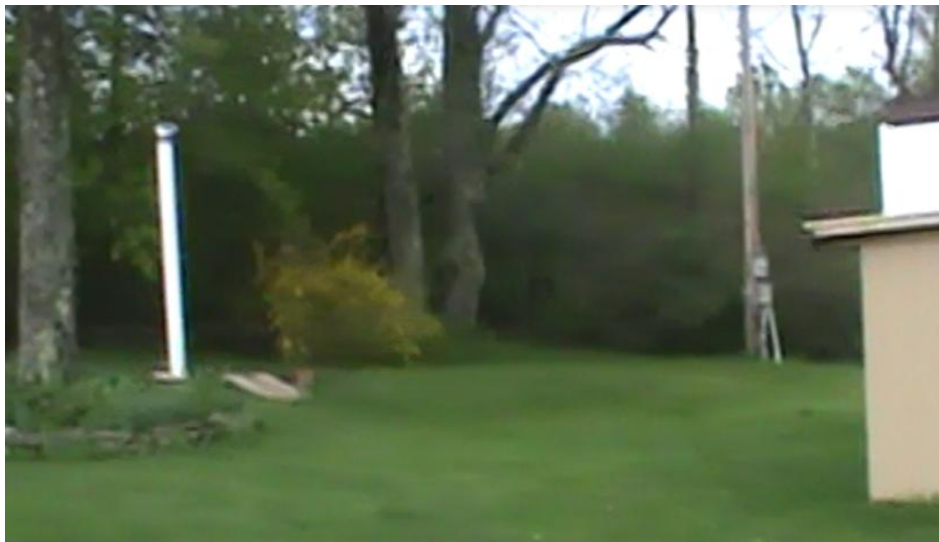
Figura 26. Esta imagen muestra la línea de ventilación para dejar escapar el gas metano del pozo de agua potable
