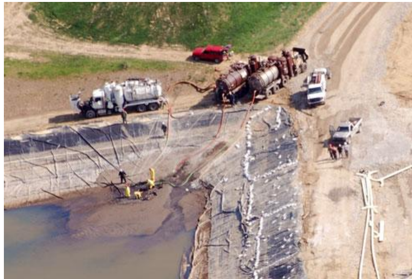
Figura 8. Construcción de una Piscina para Almacenamiento de Aguas de Desecho Localizado en el Shale de Marcellus
