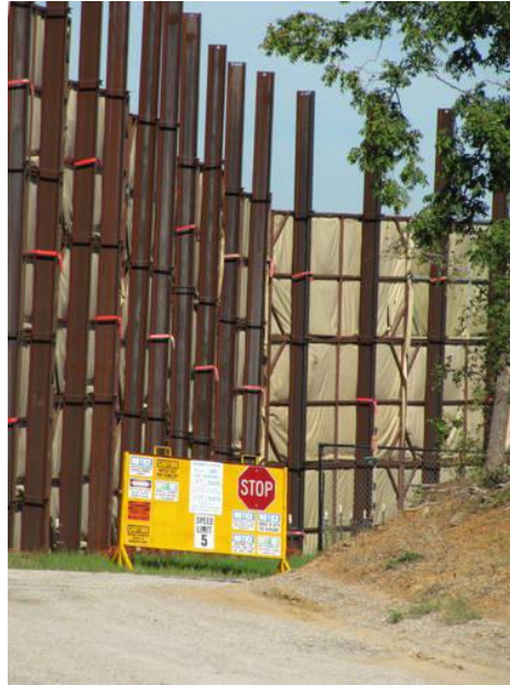
Figura 10. Muro temporal para mitigar el ruido de las operaciones de shale gas
