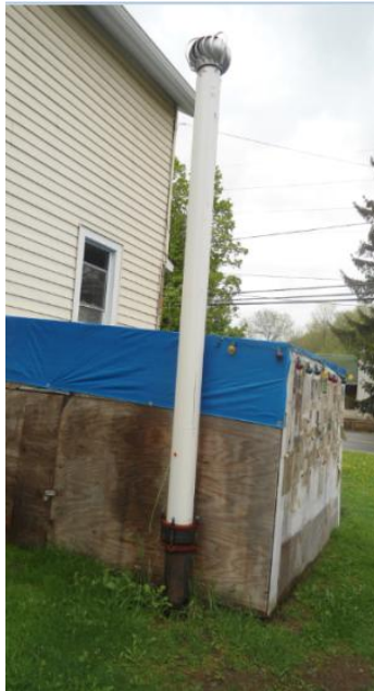
Figura 28. Pozo de agua subterráneo de la familia Manning sellado después de la explosión
