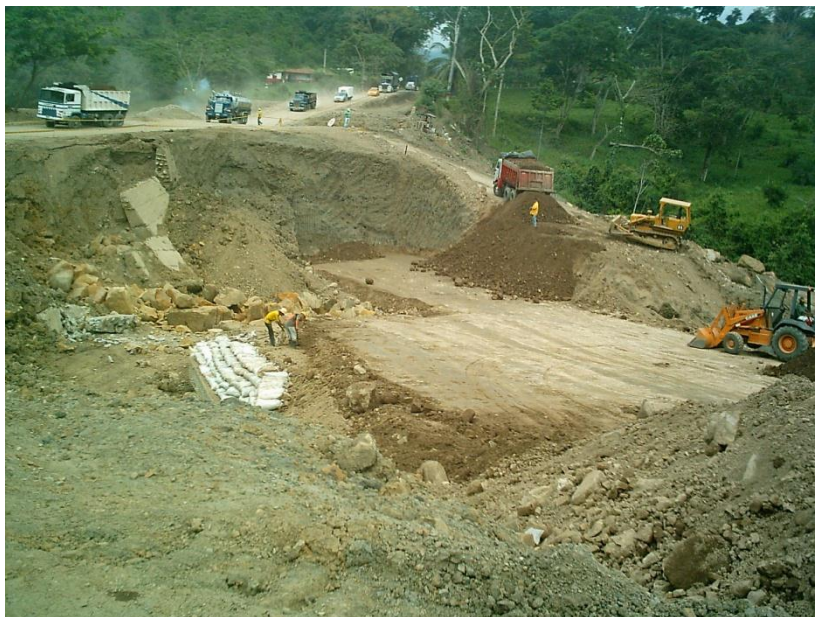
Foto 5. Trabajos de recuperación en el sector de La Leona 2007.
