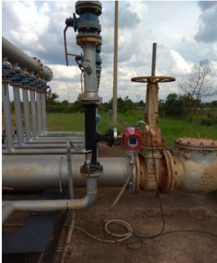
Ilustración 29: Medidor Red Eye instalado en clúster B.
