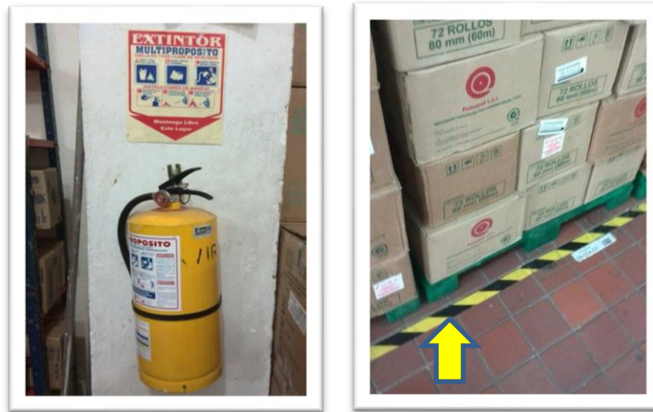
Figura 19. Señalización de lugares en bodega.
