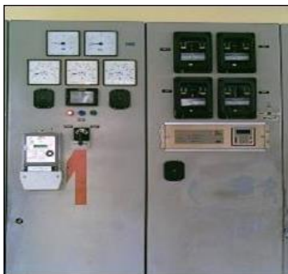
Figura 15. Celda SIEMENS RETROFIT uso tipo interior
