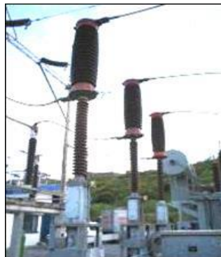
Figura 9. Interruptor de 115 kV SF6 Tipo FLX - Mando Hidráulico
