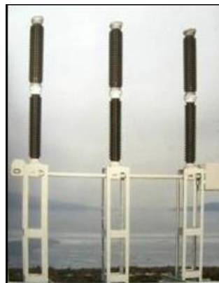
Figura 8. Interruptor de 115 kV SF6 Tipo LTB - Mando de Resortes
