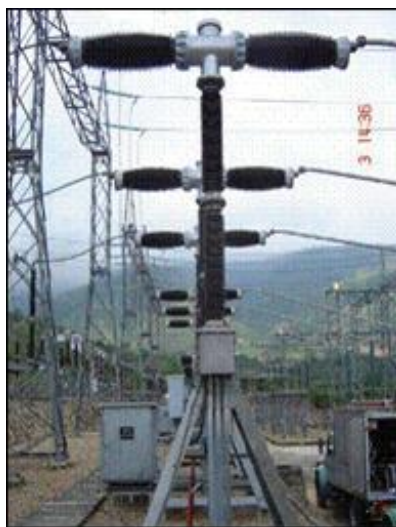
Imagen 11. Interruptor de 230kV SF6 Tipo FL - Mando Hidráulico
