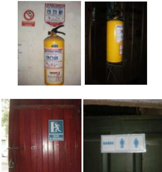
Figura 34. Señalización de lugares en bodega.
