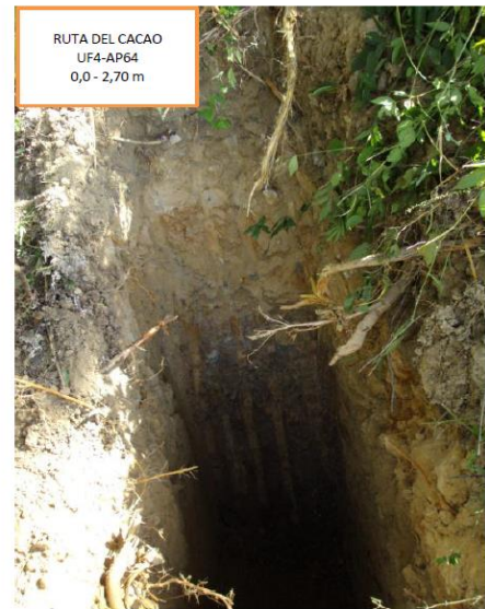
FOTO 2 - ASPECTO GLOBAL DEL APIQUE.
