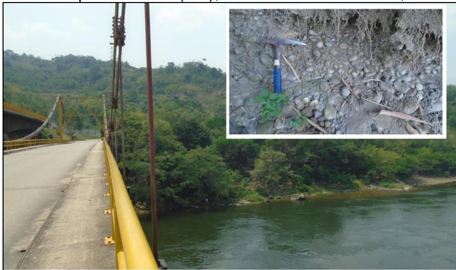
Fotografía 10. Depósito Aluvial (Qal), Puente La Paz K17+397, Río Sogamoso.
