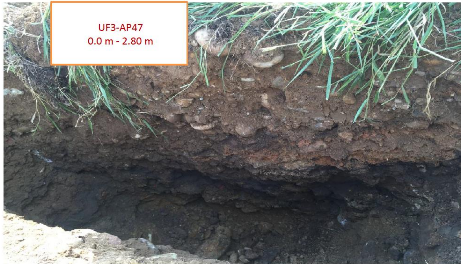
FOTO 1 - ASPECTO GLOBAL DEL APIQUE.
