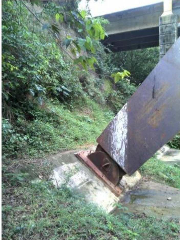
Fotografía 28. Soporte del puente La Paz, margen izquierda del Río Sogamoso.
