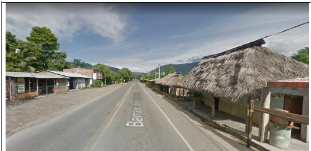
Fotografía 15. Depósito Antropogénico Qant1 de asentamiento urbano en alrededores del caserío La Tienda Nueva K13+200 al K13+500
