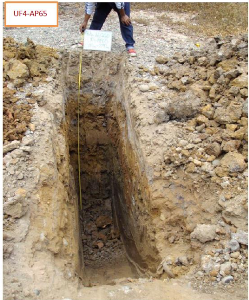
FOTO 1 - ASPECTO GLOBAL DEL APIQUE.
