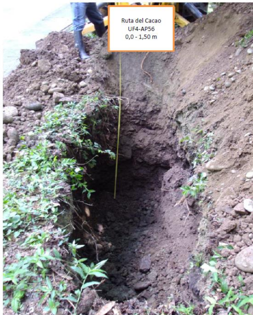
FOTO 1 - ASPECTO GLOBAL DEL APIQUE.
