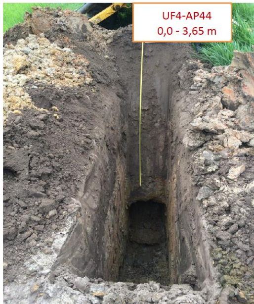
FOTO 1 - ASPECTO GLOBAL DEL APIQUE.
