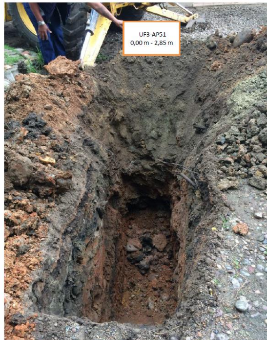
FOTO 1 - ASPECTO GLOBAL DEL APIQUE.
