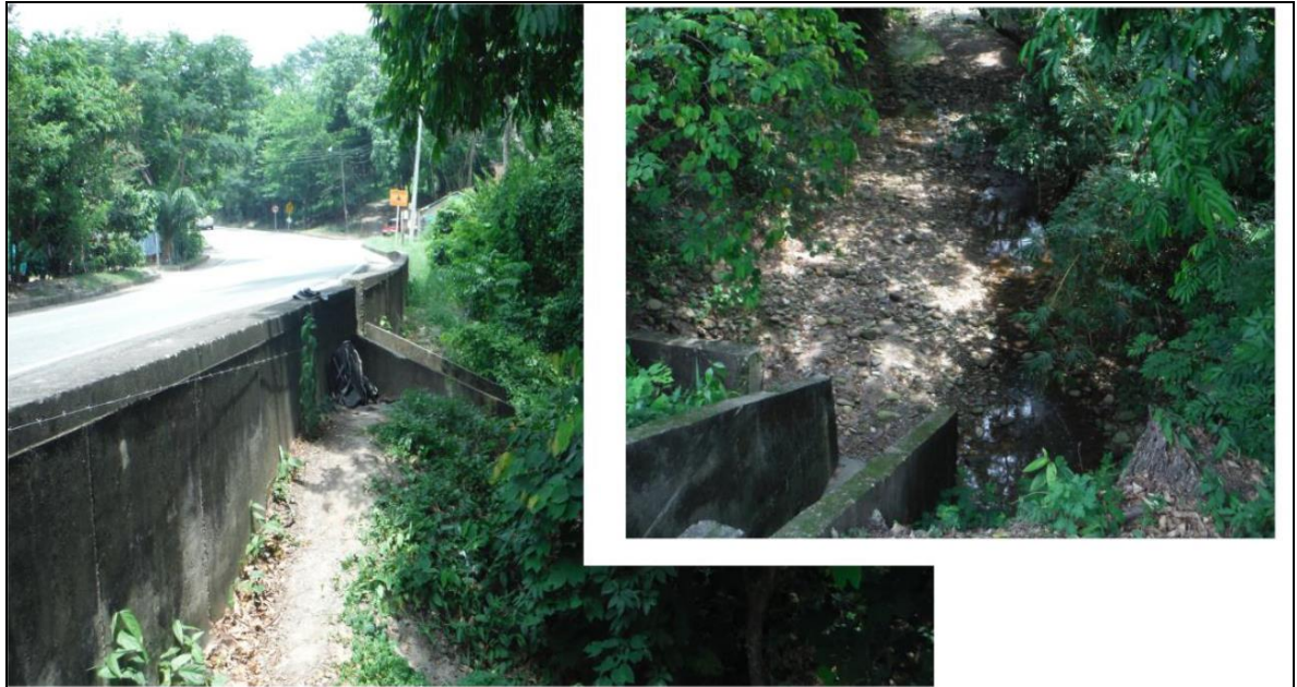
Fotografía 9. Depósito Aluvial (Qal) en quebrada controlada por Box Culvert, K15+880.
