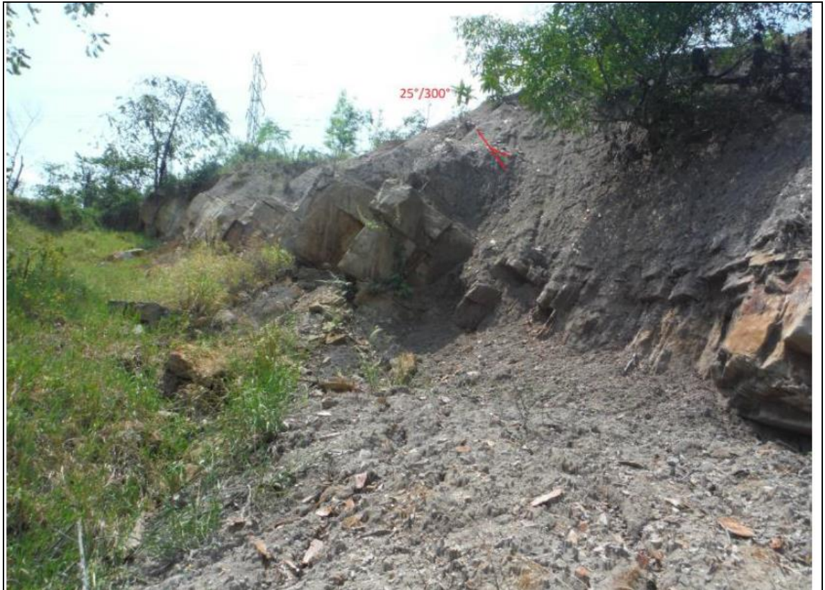
Fotografía 17. Ladera de contrapendiente sinclinal.
