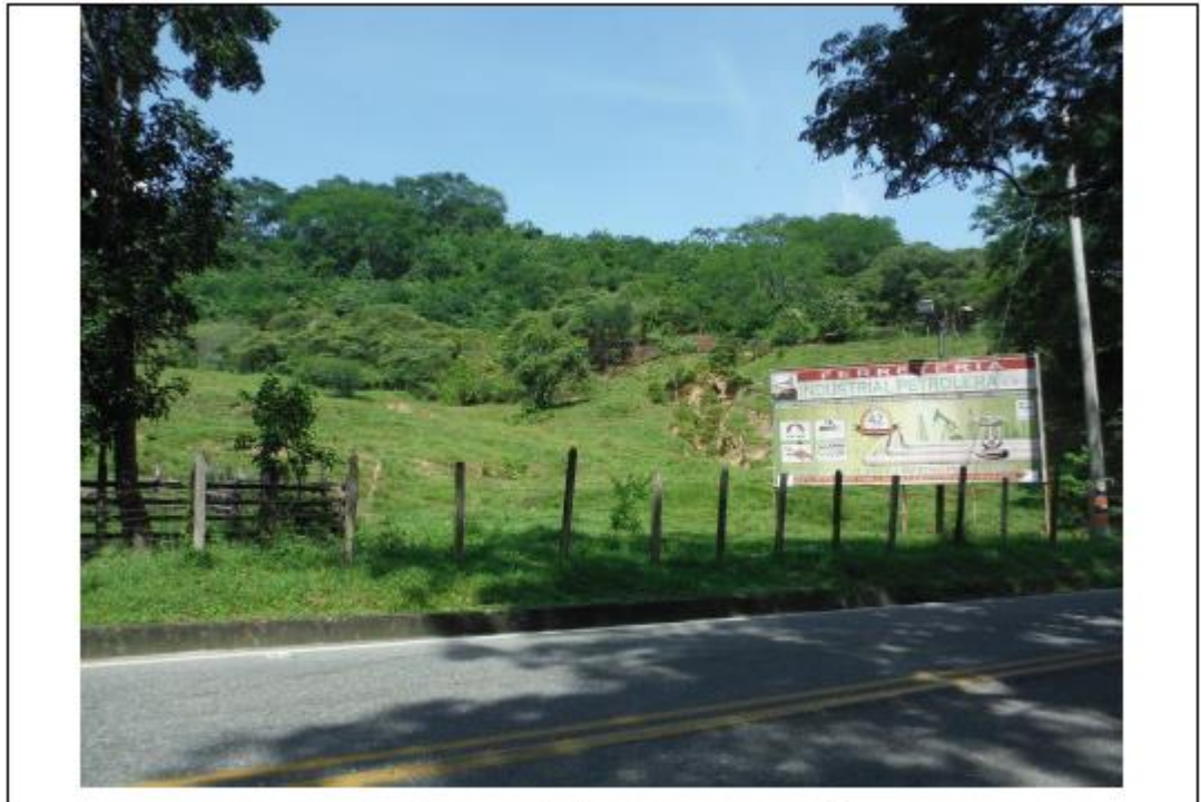
Fotografía 11. Depósito Coluvial (Qc) compuesto de suelos residuales de la Formación Esmeralda, K16+800.
