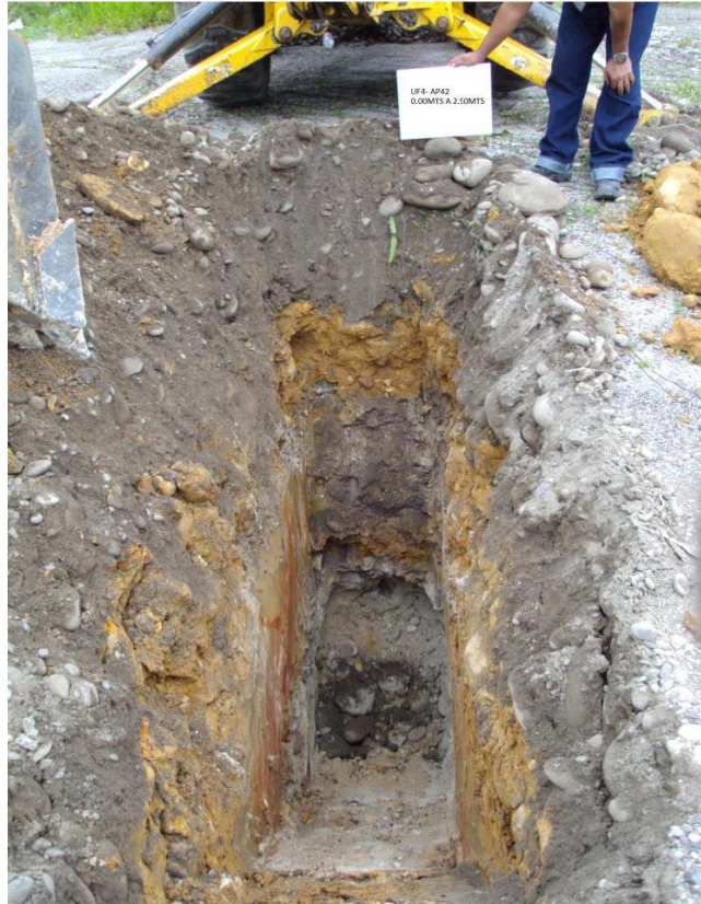
FOTO 1 - ASPECTO GLOBAL DEL APIQUE.
