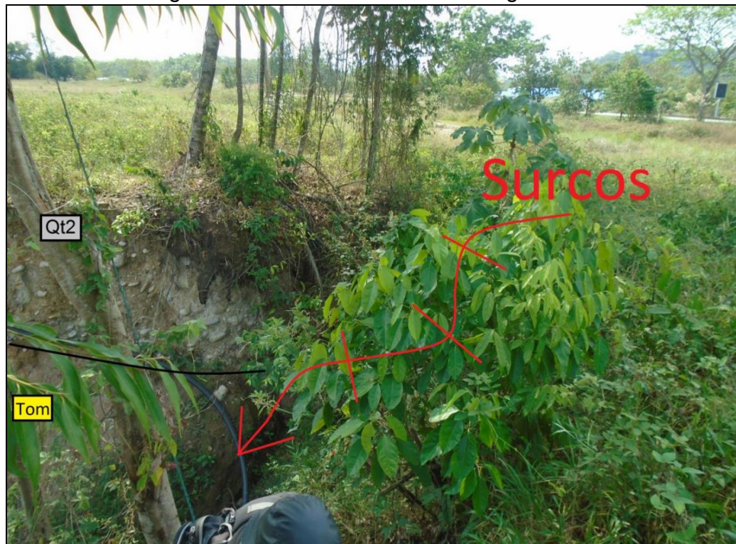
Fotografía 22. Zona de inestabilidad geotécnica.
