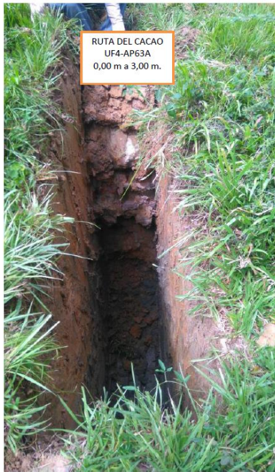
FOTO 1 - ASPECTO GLOBAL DEL APIQUE.
