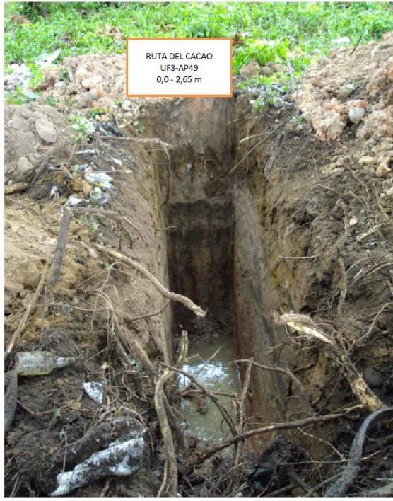
FOTO 1 - ASPECTO GLOBAL DEL APIQUE.
