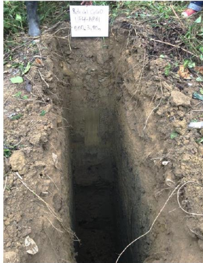
FOTO 1 - ASPECTO GLOBAL DEL APIQUE.
