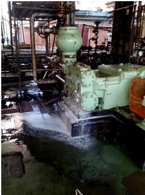
Figura 11. Derrame de producto en la bomba P1111 de aceite liviano de ciclo.
