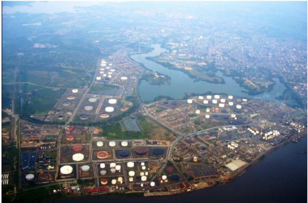
Figura 2. Gerencia Refinería Barrancabermeja.
