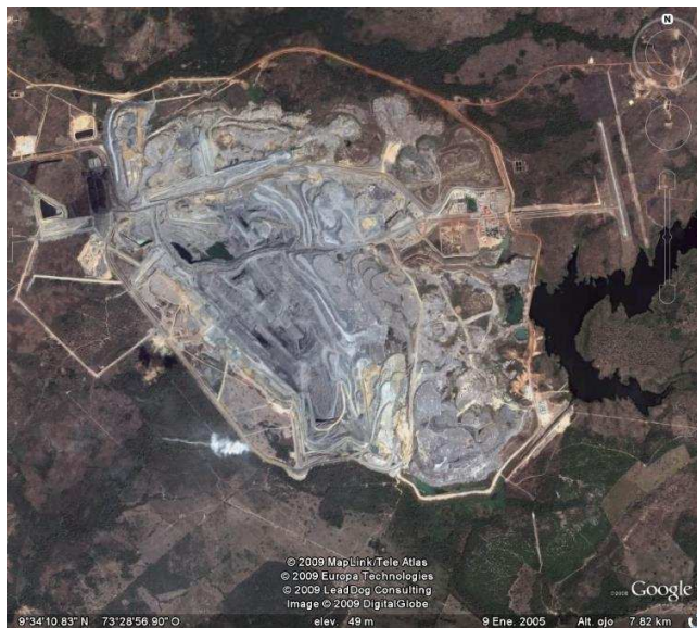
Figura 9. Frente de explotación y escombreras de la Mina de Drummond Ltda. Municipio de la Jagua de Ibirico. (google earth).
