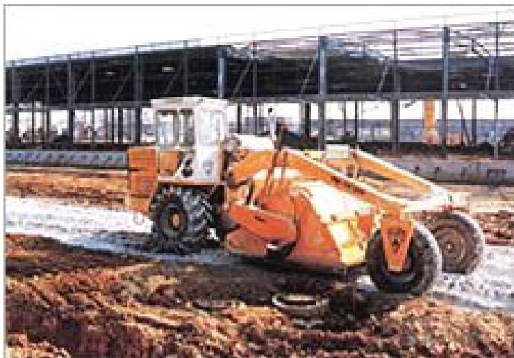
Figura 12. Cal apagada o hidróxido cálcico
