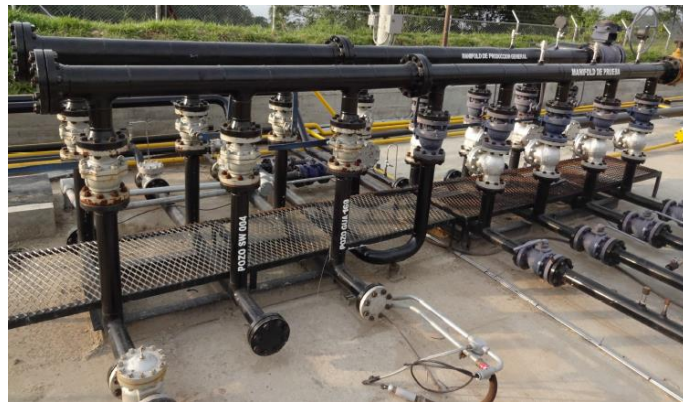
Figura 7 Manifold o Colector convencional
