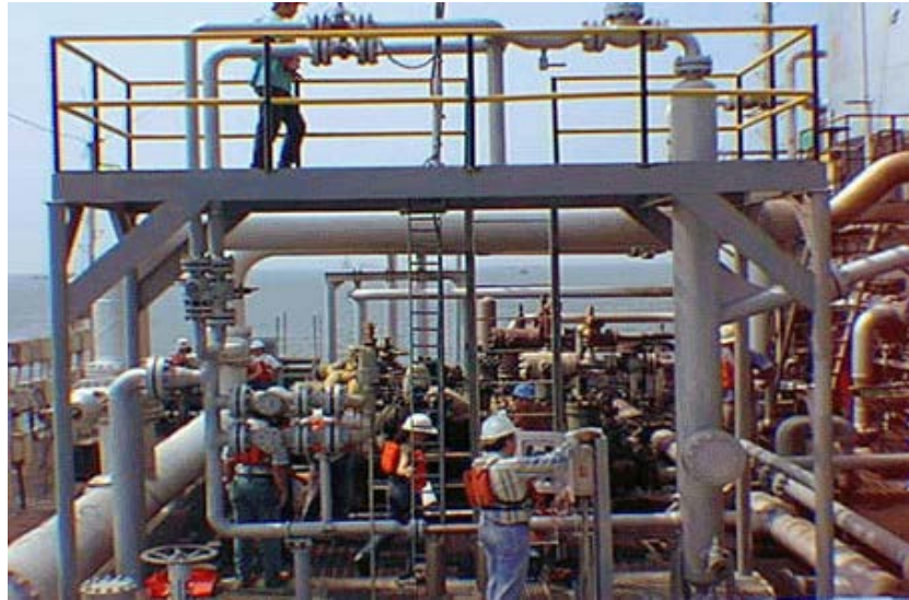
Figura 9: Separador GLCC como equipo de medición
