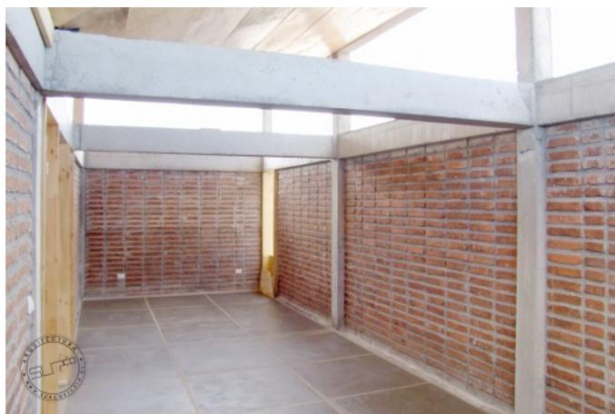
*Mampostería de Muros Confinados:* Es la construcción con base en piezas de mampostería unidas por medio de mortero, reforzada de manera principal con elementos de concreto reforzado construidos alrededor del muro confinándolo (Figura 5). Este sistema estructural se clasifica, para efectos de diseño sismo resistente, como uno de los sistemas con capacidad moderada de disipación de energía en el rango inelástico (DMO).
